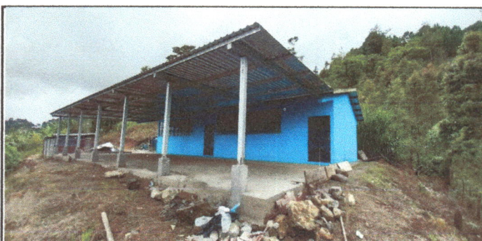
Foto 5: SE FINALIZA EL MANTENIMIENTO DE PINTURA DEL ESTABLECIMIENTO.
