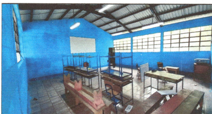
Foto 4: SE FINALIZA EL CAMBIO DEL SISTEMA DEL CABLEADO DEL ESTABLECIMIENTO Y SE PUEDE OBSERVAR EL FUNCIONAMIENTO DE LA MISMA
