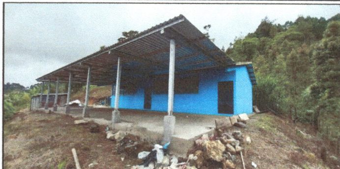
Foto 1: SE OBSERVA LA FINALIZACION DEL MEJORAMIENTO DEL ENTECHADO, CON PILARES DE CONCRETO.
