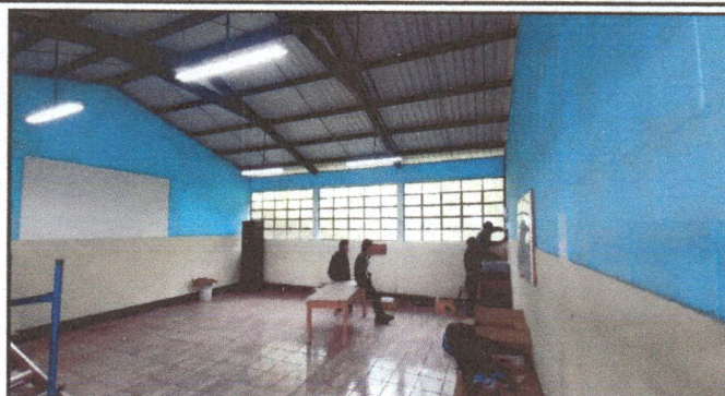
Foto 2: EN LA FOTOGRAFIA SE PUEDE OBSERVAR LA FINALIZACION DEL MEJORAMIENTO DEL PISO.
