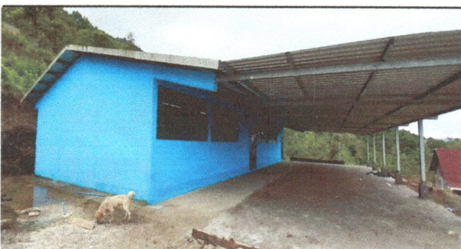
Foto 3: SE OBSERVA LA AMPLIACION DEL CORREDOR, COLOCANDO LA CAMA DE PIEDRA, POSTERIOR A LA FUNDICION Y POR ULTIMO EL SERNILLADO DE LA MISMA
